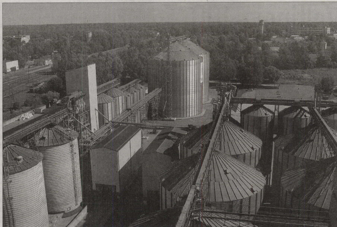
VARENI. Tā no ražotnes jumta Valmierā izskatās tikai daļa no graudu torņiem, kuros kopumā «VAKS» spēj uzglabāt līdz pat 50 000 tonnām graudu.
